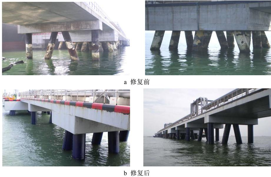
图 11 黄海海域某化工码头钢桩包覆实例
