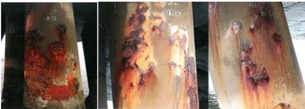
图 1 渤海海域某 LNG 码头钢桩锈蚀情况(运行 7 a)
