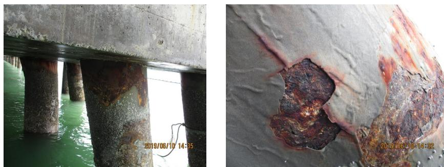
图 13 采用涂层保护钢桩腐蚀情况
