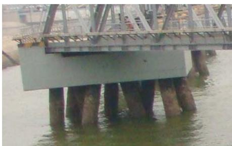
图 15 采用涂层防护的钢桩腐蚀现状
