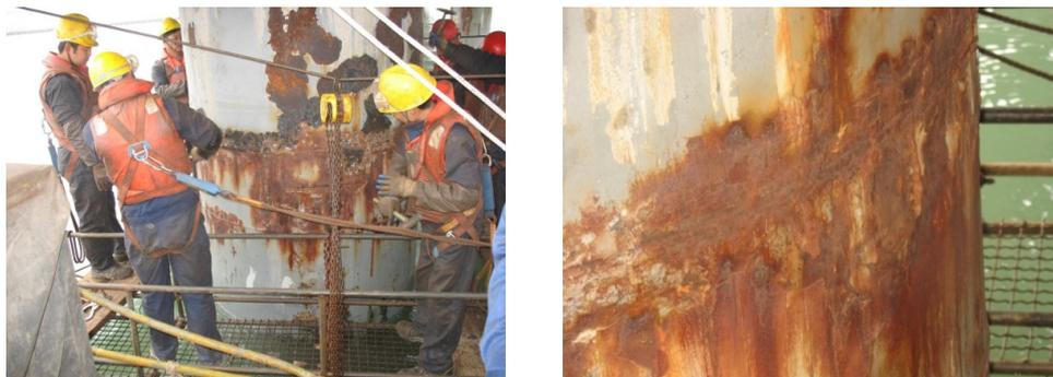
图2 东海海域某 LNG 码头钢桩腐蚀情况 (运行 5 a)
