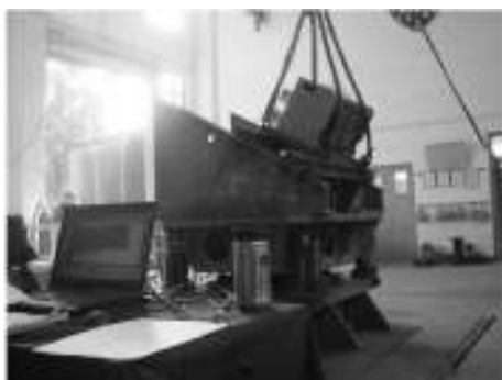
图7 断路器面板指向船舷侧外板时断路器倾斜30° 安装工况
