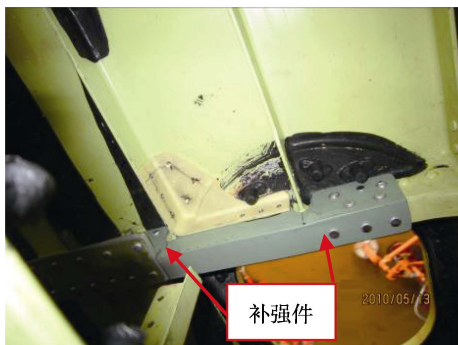
图 5 第 43 框处下壁板补强修理
