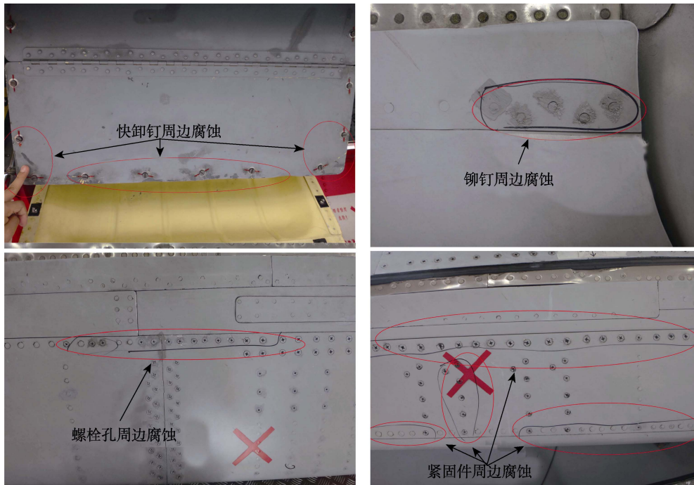
图 2 紧固件孔周边腐蚀
