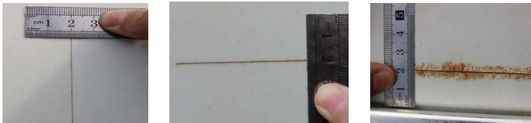
图 4 发动机舱盖、车门、车顶划线及腐蚀状态
