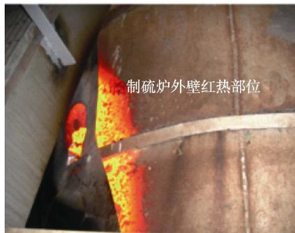
变形量越大，内部衬里承受的拉应力就越大，进而造成耐火砖断裂引发塌落。由于高温过程气通过裂缝进入衬里与炉壁之间，造成锚固钉腐蚀断裂，进一步造成衬里脱落。
