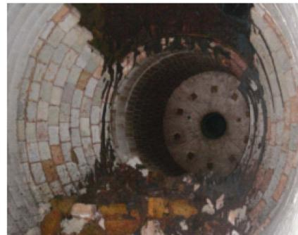
图 2 制硫炉炉体腐蚀部位
